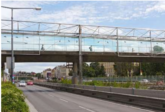
Gläserner Windschutz an Brücken und verglaste Verbindungsgänge gehören zu den augenfälligsten Vogelfallen. vielerorts sieht man aufgeklebte Greifvogelsilhouetten. Diese sind zwar unwirksam, bestätigen aber, dass es hier zu Anflügen kommt.
