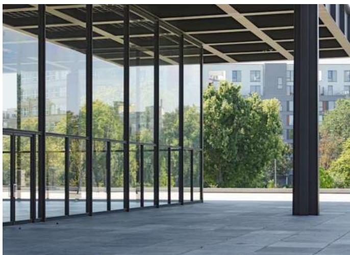
Transparenz und Offenheit als Ideal der Moderne prägen die Architektur der Neuen Nationalgalerie Berlin. Für Vögel wird der freie Blick durch das gläserne Gebäude zur tödlichen Falle.
