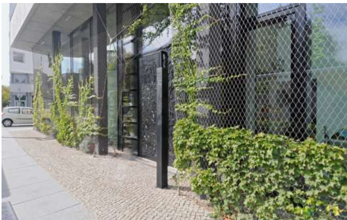
Stahlnetze, wie sie häufig zur Gebäudebegrünung genutzt werden, können bei richtiger Seilstärke auch dem Vogelschutz dienen. Bei dem Entwurf des PHED Passivhauses von scarchitekten joerg springer/robert mieth in Berlin wurde diese Form der Fassadengestaltung von Anfang an eingeplant. Je nach Fassadenbeschaffenheit können entsprechende Netze aber auch nachträglich installiert werden.
