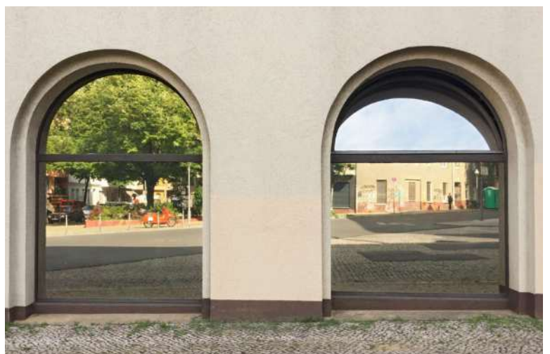
Spiegelnde Sonnenschutzfolien erzeugen realistische Spiegelbilder: Vögel nehmen diese Fenster als Durchflugsloption wahr.
