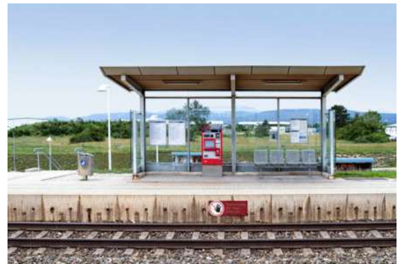
Fahrgastunterstände werden vielfach in Glas ausgeführt, ohne an Sicherungsmassnahmen für Vögel zu denken.
