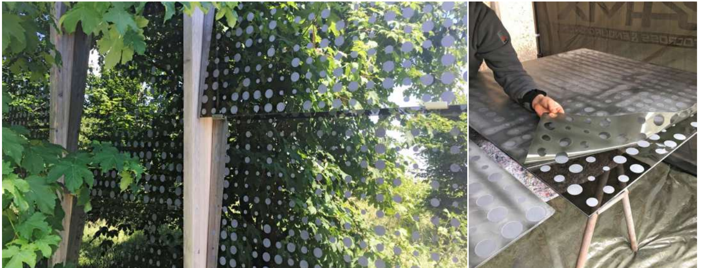
Eine nachträglich sandgestrahlte Fassade in Scharnstein: Für die Nachrüstung konnten die einzelnen stark spiegelnden Gläser von der Fassade abgenommen werden. Anschliessend wurden sie vor Ort durch partielles Sandstrahlen (lochkartenartiges Punktraster wechselnder Durchmesser) im Sinne des Vogelschutzes verändert.
