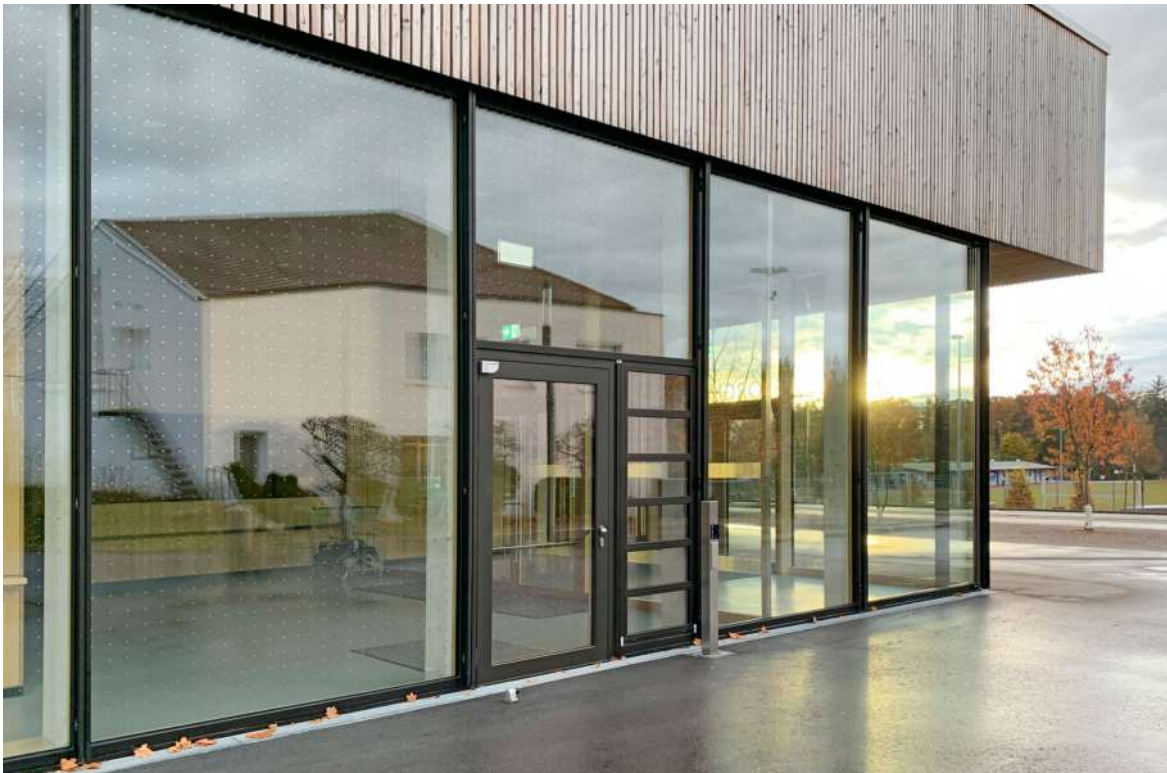
Dieses Raster aus 9 mm starken metallischen Punkten in 90 mm Abstand ist im Inneren einer Isolierglasscheibe einlaminiert und dennoch hoch wirksam. Schwarze Markierungen konnten wegen Spiegelungen bisher nur auf der Aussenseite der Fassadengläser reüssieren.
