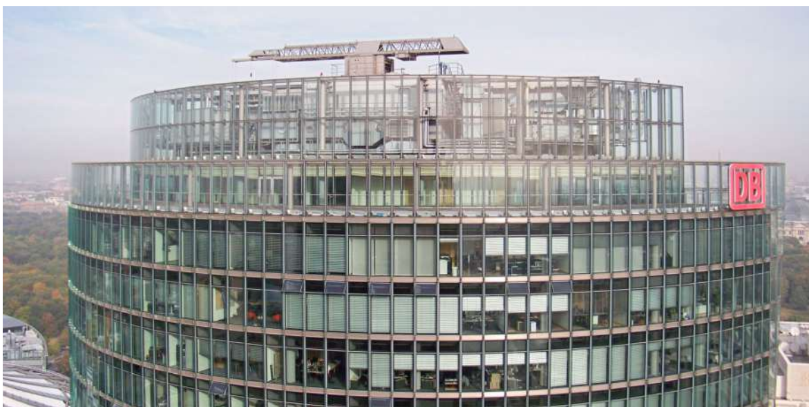
Meterhohe gläserne Attika auf einem Hochhaus: Vögel kollidieren hier nicht nur von aussen, sondern prallen auch von innen an die Scheiben, wenn sie in den umschlossenen Bereich geraten.
