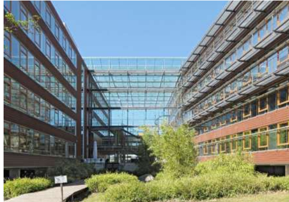
In begrünten Innenhöfen oder mehrseitig umschlossenen Gebäudebereichen erhöht sich das Kollisionsrisiko an Glasflächen. Vegetation zieht Vögel beim Flug über das Häusermeer an. Der Wegflug im steilen Winkel kann hingegen schwierig werden.
