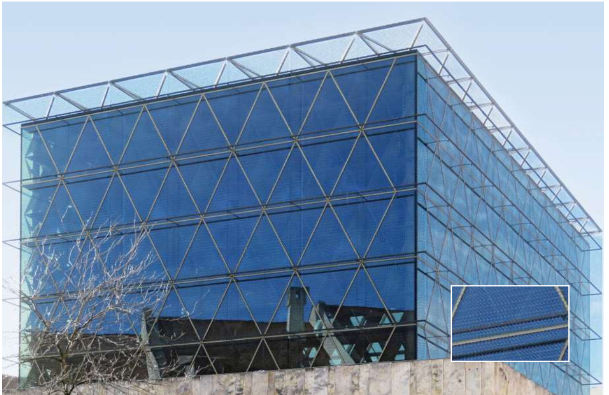
Der Glaskubus des Jüdischen Zentrums von Wandel Hoefler Lorch + Hirsch in München ist umgeben von einer stählernen Stützkonstruktion und einem Bronzegewebe. Ein Dreiecksmuster aus Davidsternen sorgt durch das Spiel von Licht und Schatten im Gebetsraum für eine besondere Atmosphäre.
