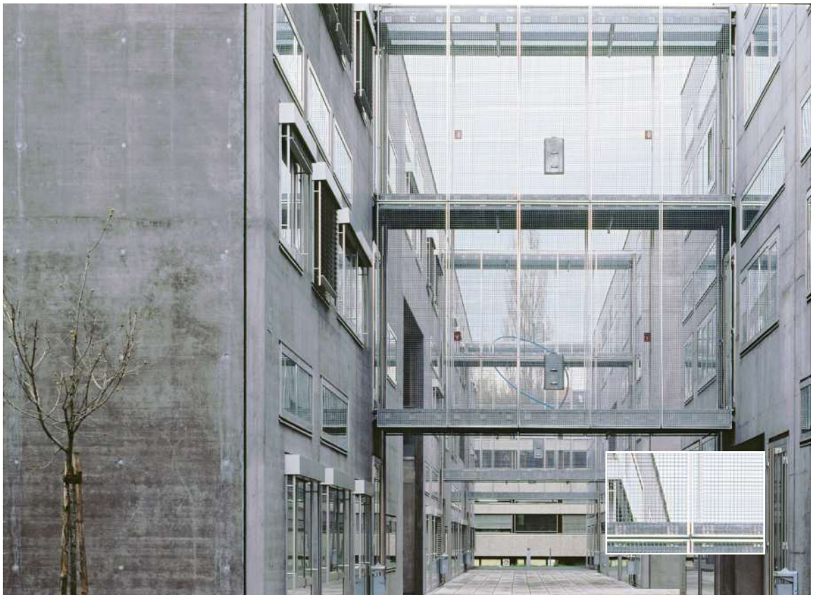
Die einzelnen Baueinheiten der Technischen Universität Graz vom Architekturbüro Riegler Riewe sind durch mehrgeschossige Brücken miteinander verbunden. Die Fassadenelemente aus Stahlgitter gewähren Durchsicht und Lichteinfall und sind für Vögel trotzdem gut als Hindernis erkennbar.
