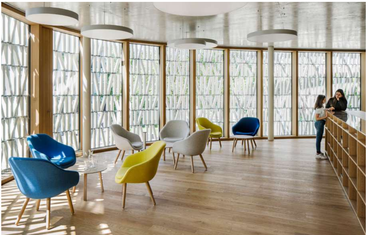
Der ovale Glaspavillon der Stadtbibliothek Dornbirn von Dietrich | Untertrifaller ist eingehüllt in eine Struktur aus 8000 vorgefertigten Keramikelementen. Vertikal und schräg angeordnet, erinnern die Sonnenschutz-Ornamente an Bücherregale und sorgen für einen angenehmen Lichteinfall in den Räumlichkeiten.
