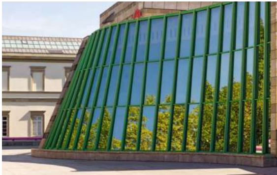
Glas mit seiner glatten Oberfläche spiegelt, wann immer der Hintergrund schwächer beleuchtet ist als der Vordergrund. Zusätzliche Beschichtungen der Fassadengläser können die Kontraste der Spiegelungen verstärken. Für Vögel vermitteln nicht nur gespiegelte Bäume, sondern auch gespiegelter Himmel freien Bewegungsraum.
