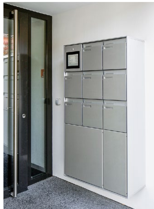
Gewerbe- und Wohnhaus, Seestrasse, Erlenbach 1 PaketboxPlus-Anlage, fertiggestellt im November 2016
