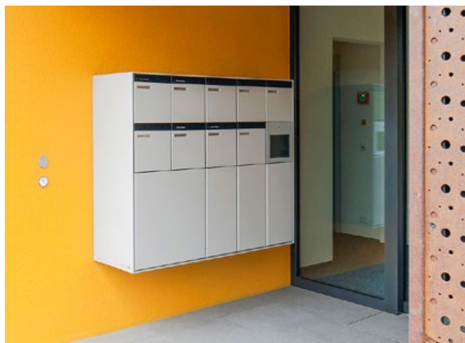
MFH, Hauptstrasse, Alterswil 1 PaketboxPlus-Anlage, fertiggestellt im August 2015
